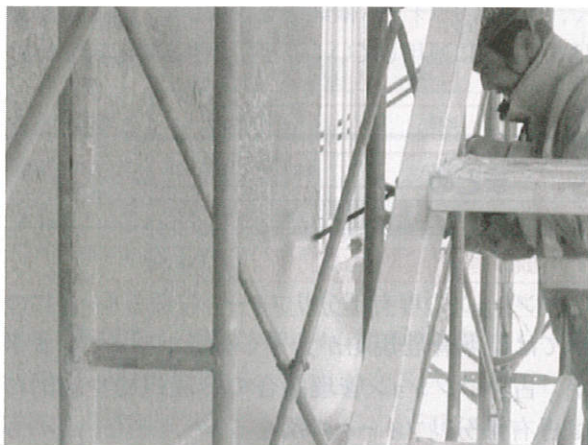
写真1 超高压洗浄による外壁塗膜の剥離作業
