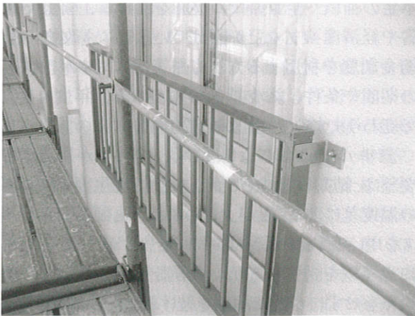
写真3 アルミ製のものに交換された窓手摺
