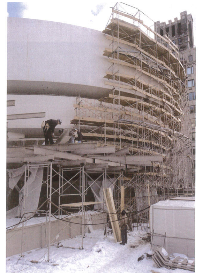
写真⑤ グッゲンハイム美術館改修時の足場設置状況 (2005年、グッゲンハイム美術館50周年記念誌より)
