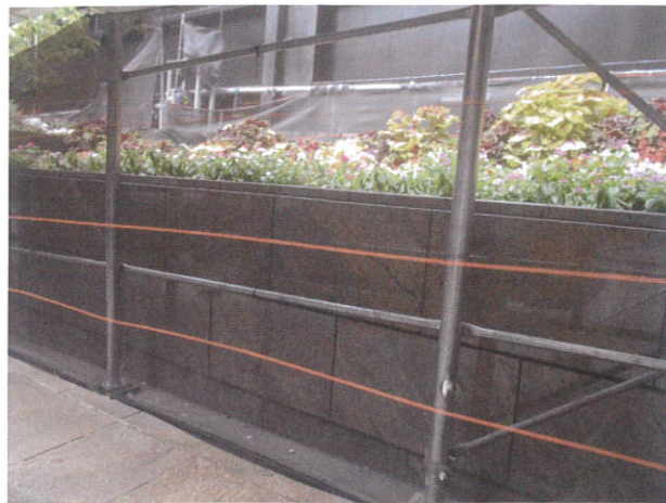
写真⑦ マンハッタン、ダウントウン地区のビル改修現場にて (2015年に筆者が撮影)
