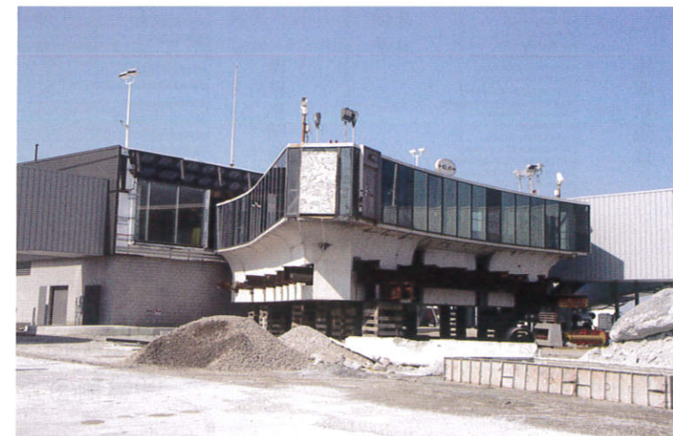
写真㉚ 曳屋工法により一部保存された「トランペット」(撮影: Ian A. Duncan)
