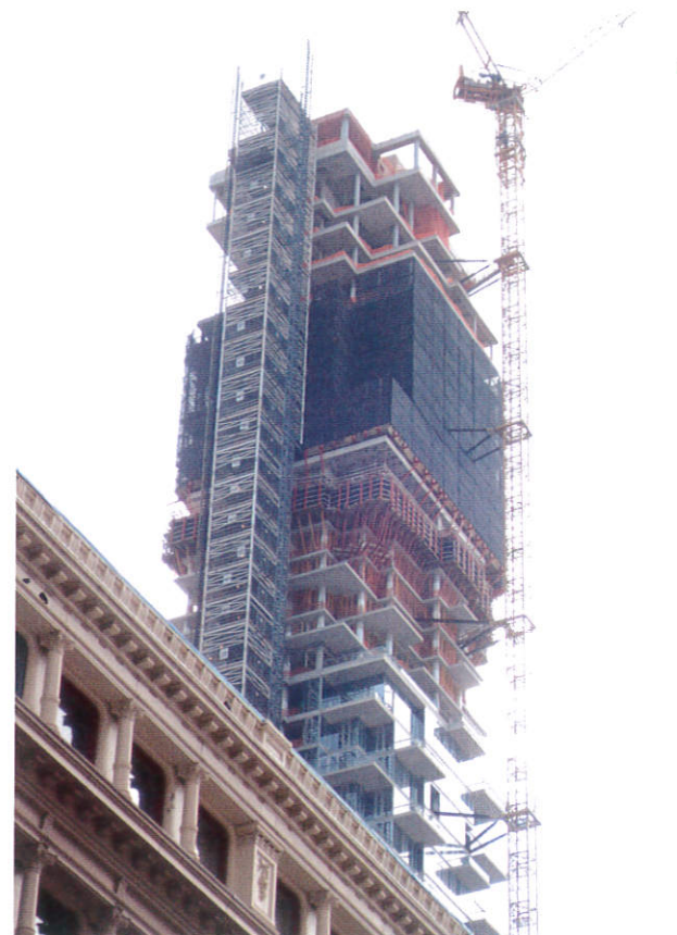
写真㉒ 工事中のヘルツォーク&ド・ムーロン設計タワー型マンション（2015年に筆者が撮影）
