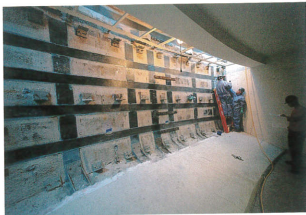
写真⑨ ロタンダの内側の躯体壁に施された、炭素繊維プレートによる補強。(出典：The New York Times, 2007/09/10)
