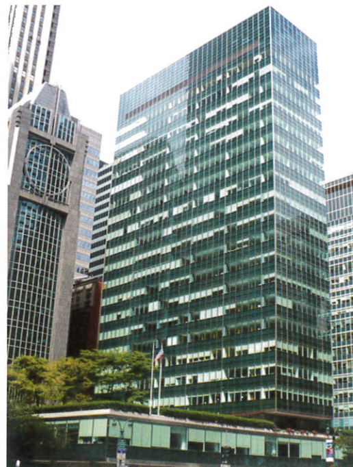
写真③ レバーハウス(Lever House)。1952年竣工。設計はSOM(スキッドモア・オーウィングス&メリル)。市内初のガラス・カーテンウォールのビル。2001年に、スチール製フレームとガラス等、全てのカーテンウォール部材が、ステンレス製の枠と新しいガラスに更新されている。
